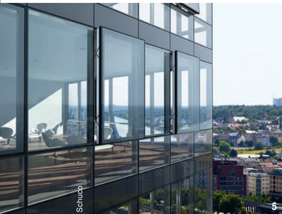
5–9. Основное преимущество алюминия — легкость и прочность, благодаря чему из него можно делать большие по размеру конструкции без применения дополнительных материалов
